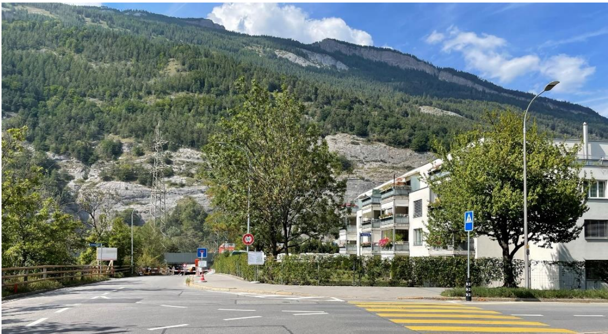
Vom Schwerverkehr betroffen, Wohnhaus Austrasse 1
